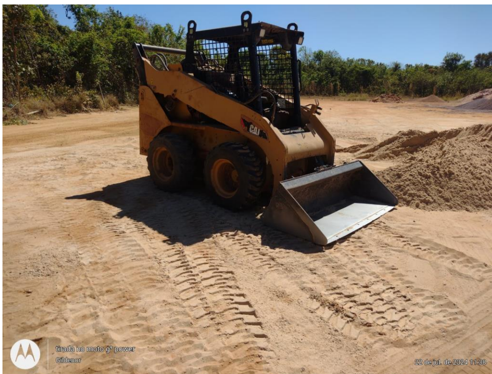
Figura 8: Estoque de areia e pedra brita
